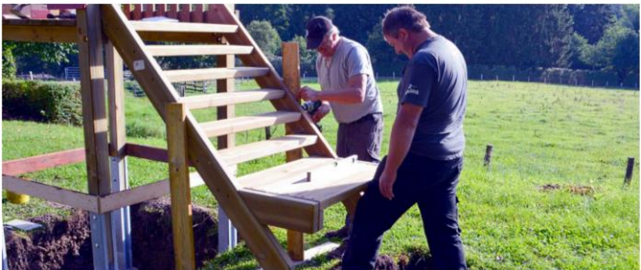
Die Gemeindetechniker beim Errichten des Spielplatzes
