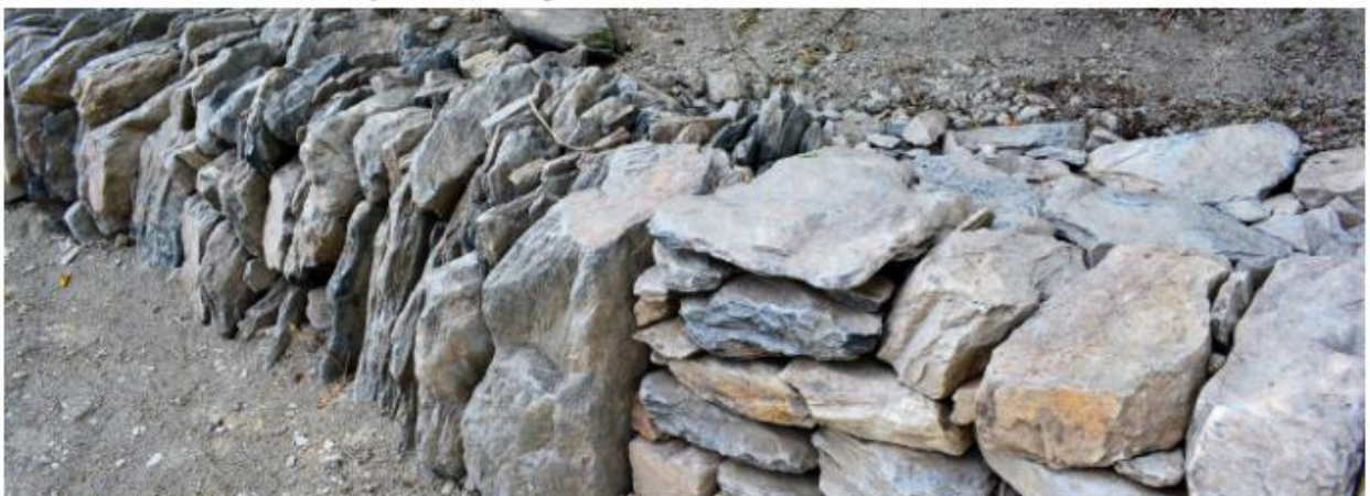
Vorige Seite Bild 1) und 2): Die fertige Trockenmauer. Diese Seite: Die ‚Mauerkünstler‘ und ihre Helfer bei der schweisstreibenden Arbeit. - Unten: So sind die einzelnen Steine auf- und ineinander geschichtet.
